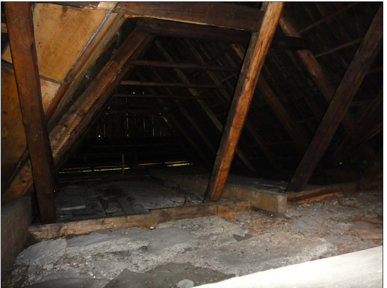
FOTOGRAFIA NR 14 KONSTRUKCJA DACHU 4
