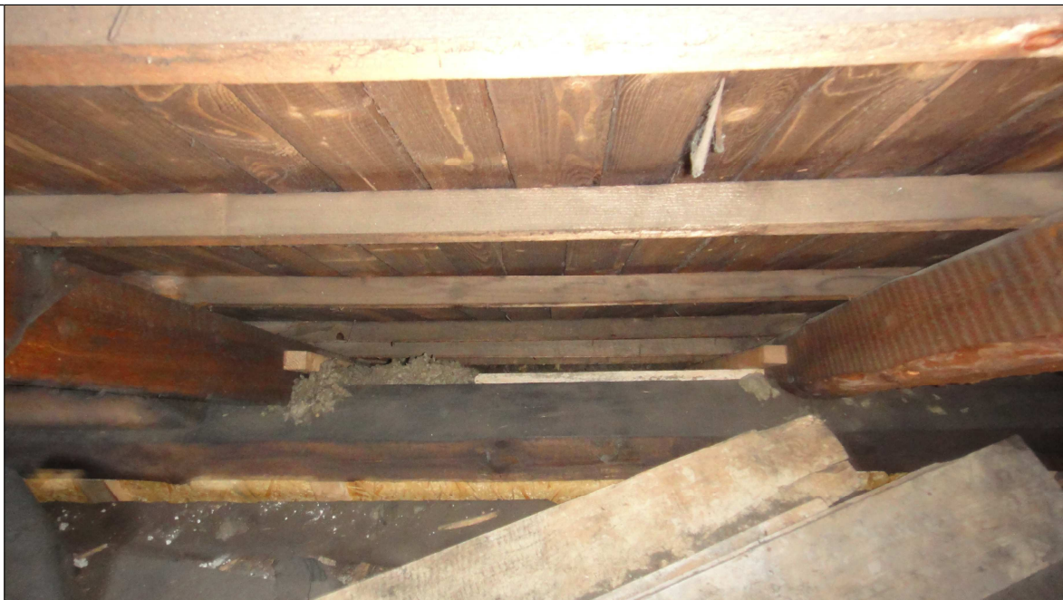
FOTOGRAFIA NR 11 KONSTRUKCJA DACHU 1
