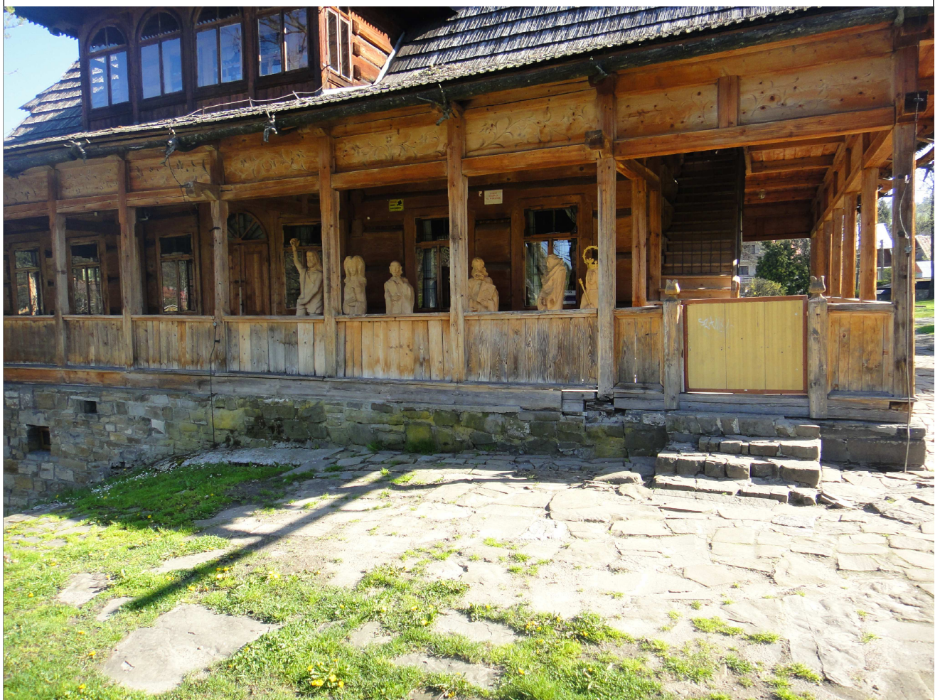
FOTOGRAFIA NR 10 BALUSTRA DA GANKU
