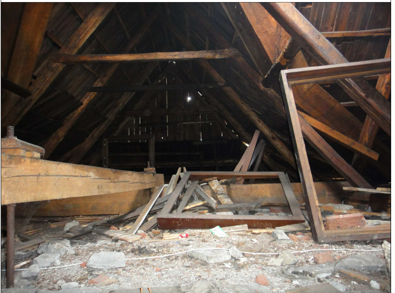
FOTOGRAFIA NR 15 KONSTRUKCJA DACHU 5
