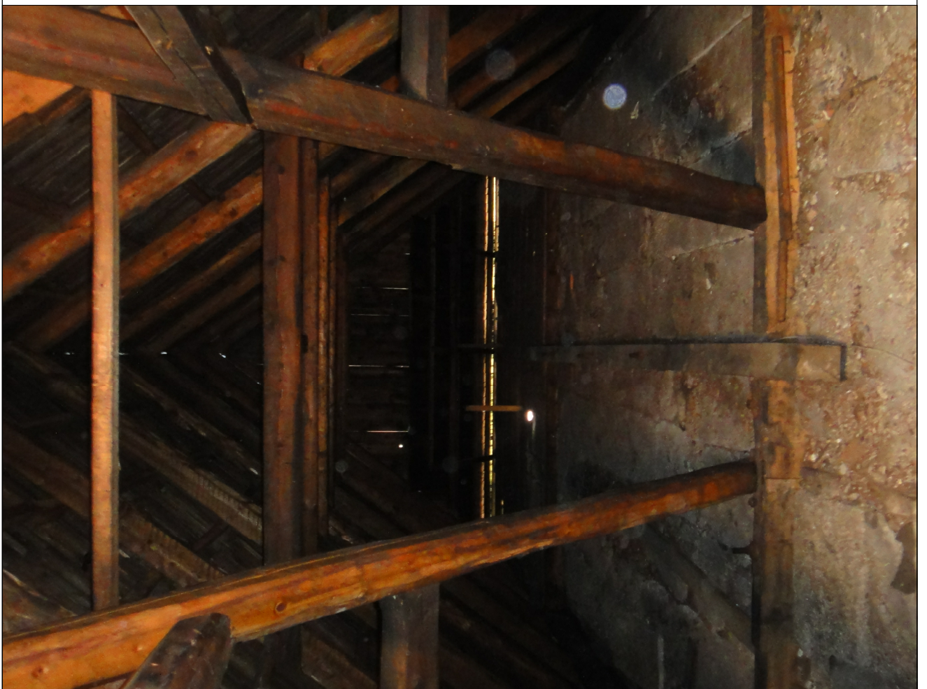
FOTOGRAFIA NR 17 KONSTRUKCJA DACHU 5
