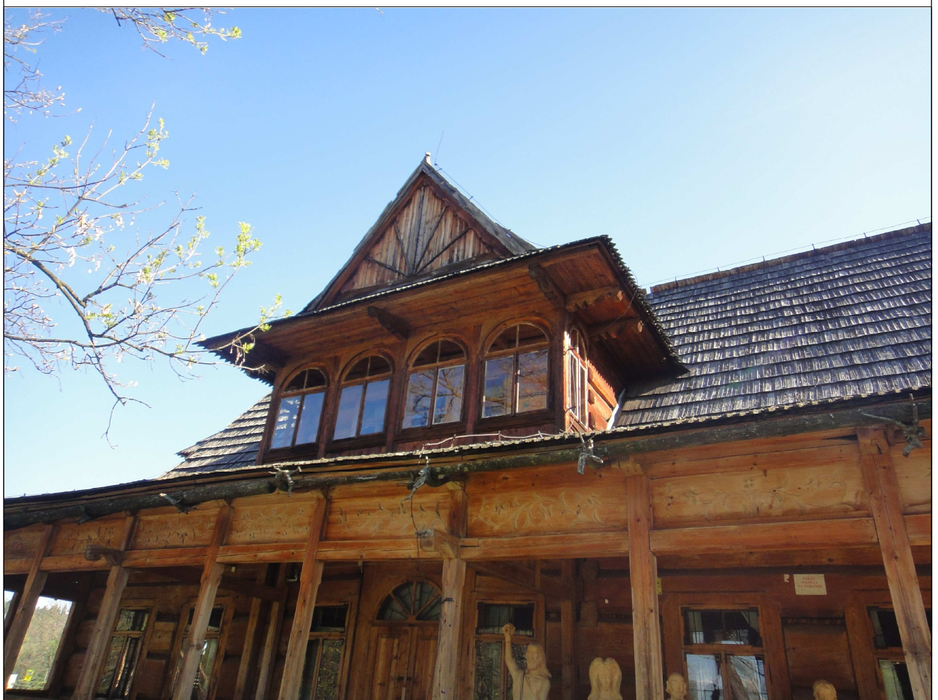
FOTOGRAFIA NR 8 OTWARCIE DACHOWE OD STRONY POŁUDNIOWEJ
