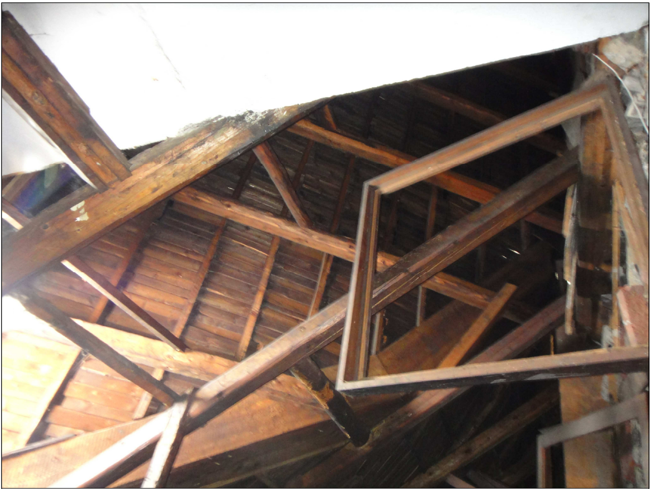
FOTOGRAFIA NR 16 KONSTRUKCJA DACHU 4
