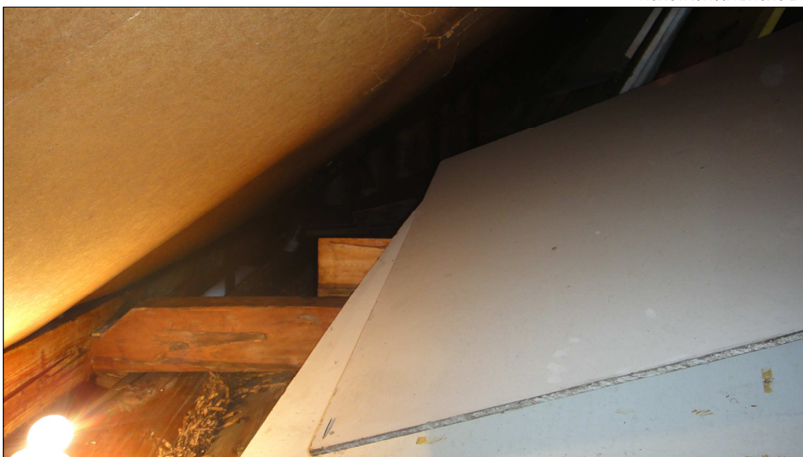
FOTOGRAFIA NR 13 KONSTRUKCJA DACHU 3
