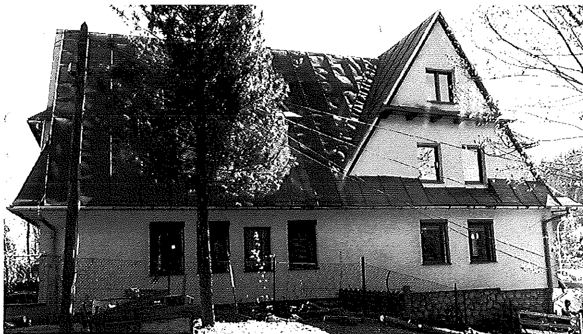
Fot. 5. Poronin, ul. Piłsudskiego 5, elewacja północna.
