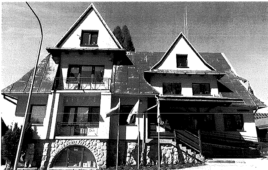
Fot. 2. Poronin, ul. Piłsudskiego 5, elewacja południowa.
