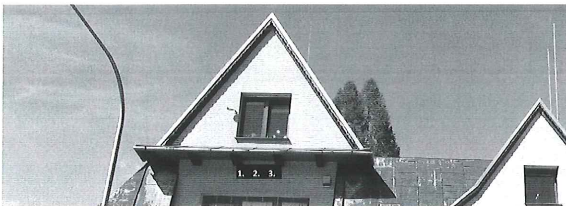
Fot. 8. Poronin, ul. Piłsudskiego 5, elewacja południowa, czarny prostokąt (gniazda są 3 razem) wskazuje miejsce zamocowania 3 sztucznych gniazd z zabezpieczeniem przeciw brudzeniu elewacji dla oknówek.
