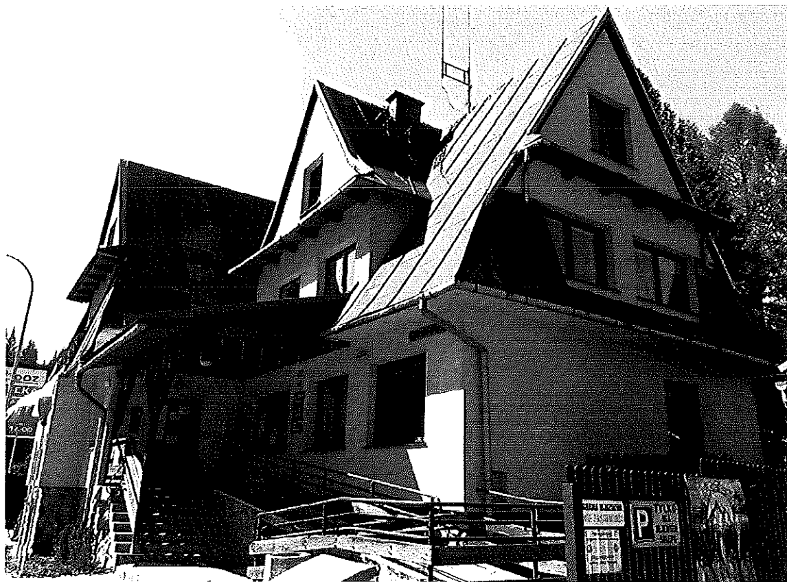
Fot. 3. Poronin, ul. Piłsudskiego 5, elewacja południowa i wschodnia.
