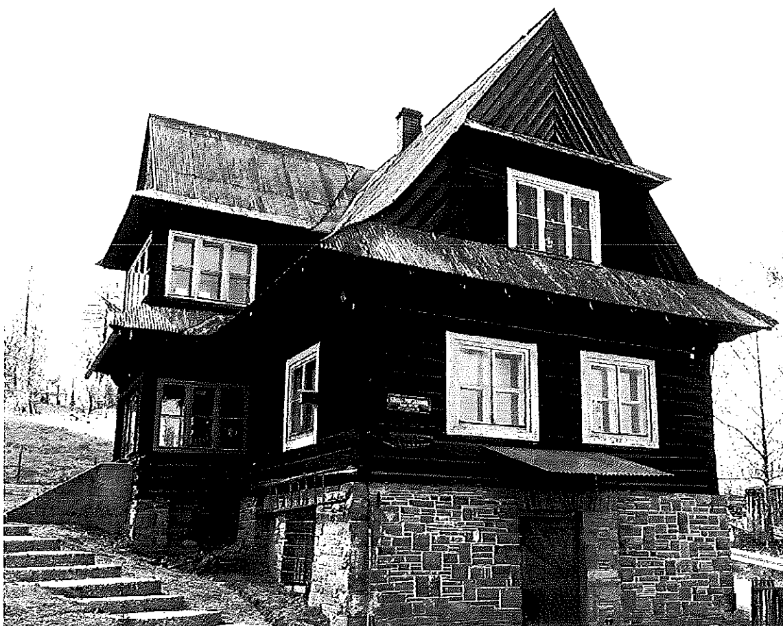
Fot. 3. Nowe Bystre 180B, elewacja południowa i wschodnia.
