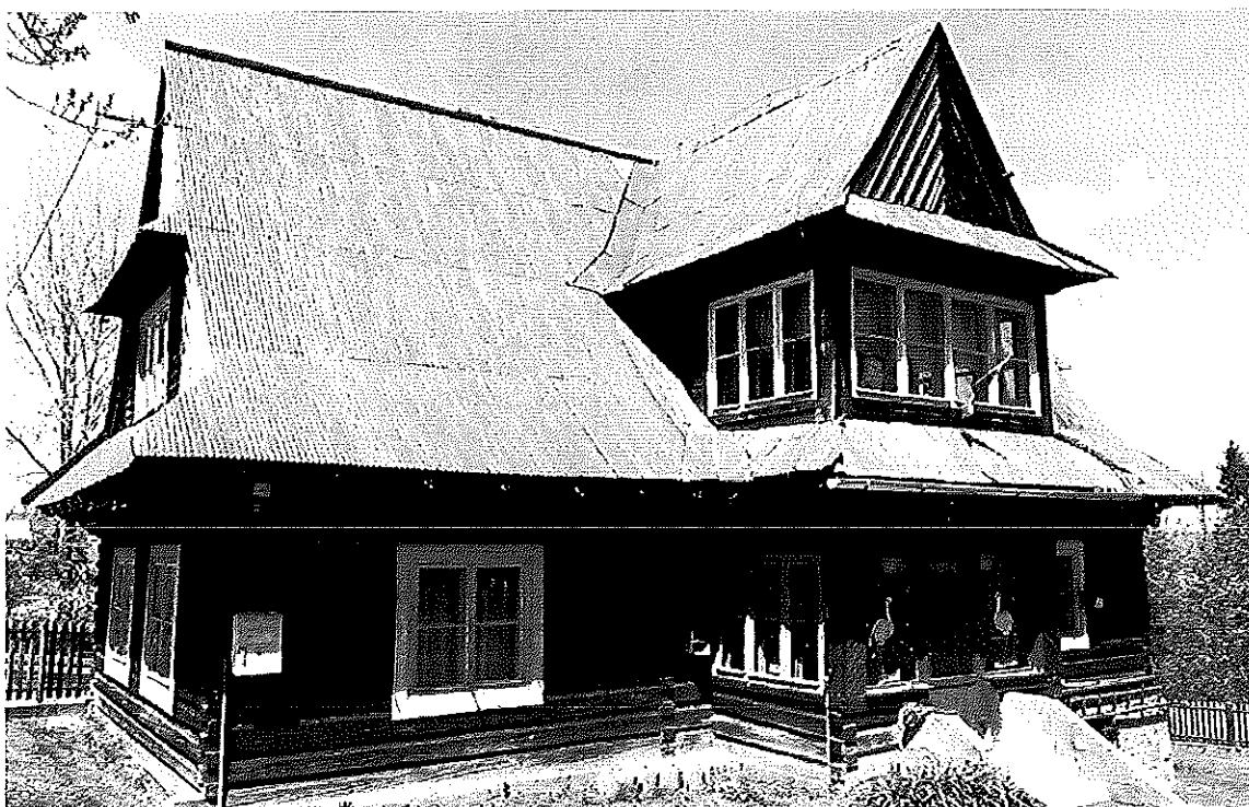
Fot. 2. Nowe Bystre 180B, elewacja zachodnia i południowa.
