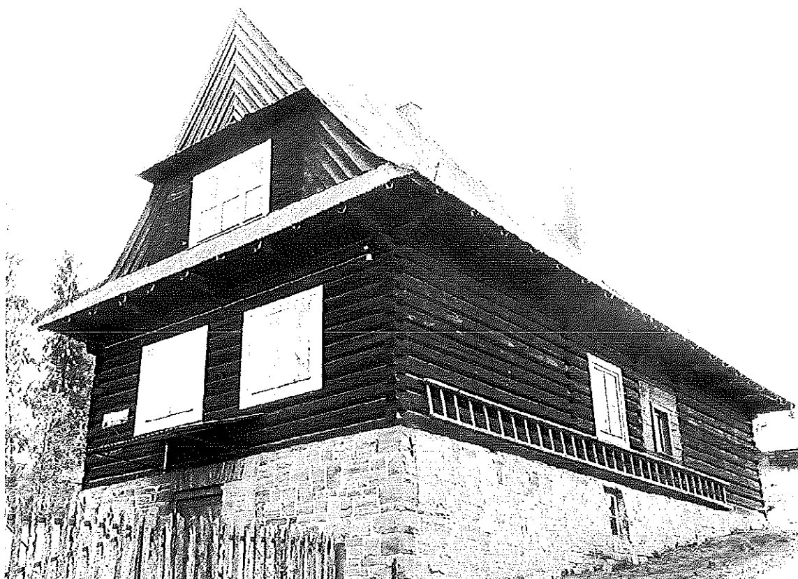
Fot. 4. Nowe Bystre 180B, elewacja wschodnia i północna.
