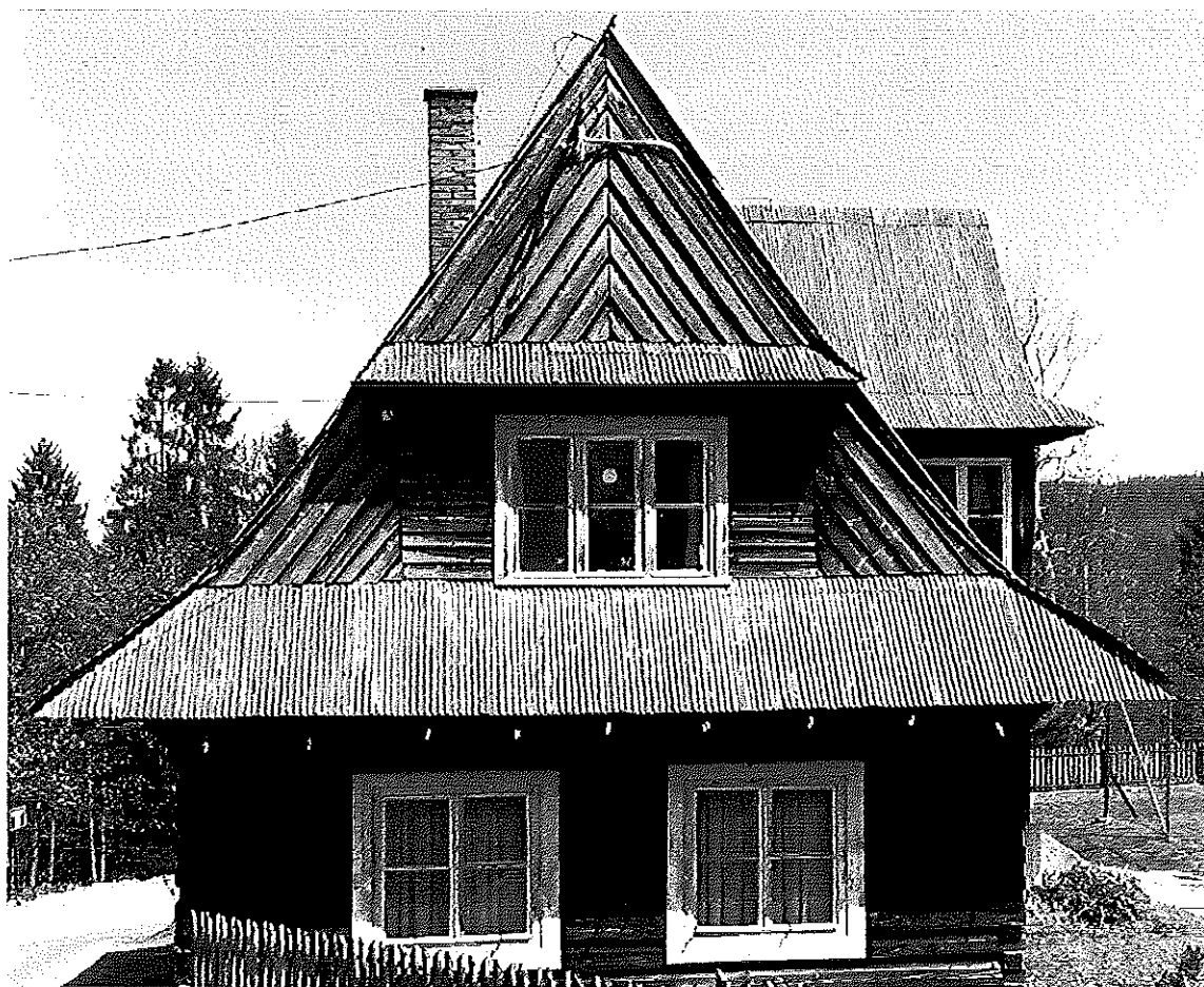
Fot. 5. Nowe Bystre 180B, elewacja zachodnia.
